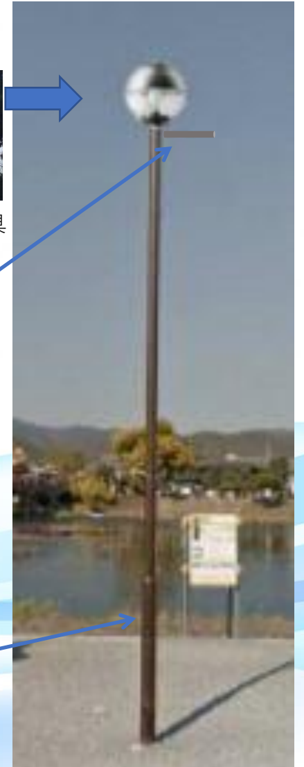
ポールは既存のものを使用 灯具交換 (密閉型に変更)
